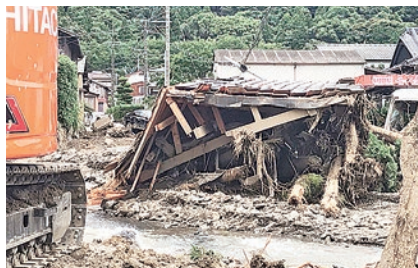
田主丸竹野地区で土砂崩れにより倒壊した建物
