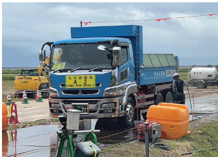
佐賀空港西隣の駐屯地建設工事現場に土砂を運んできたダンプカー
