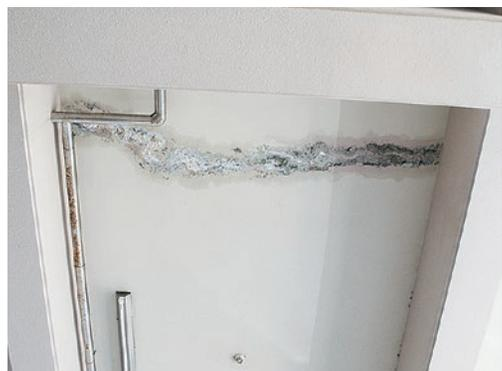
駐車場の天井が雨漏りで腐食している
